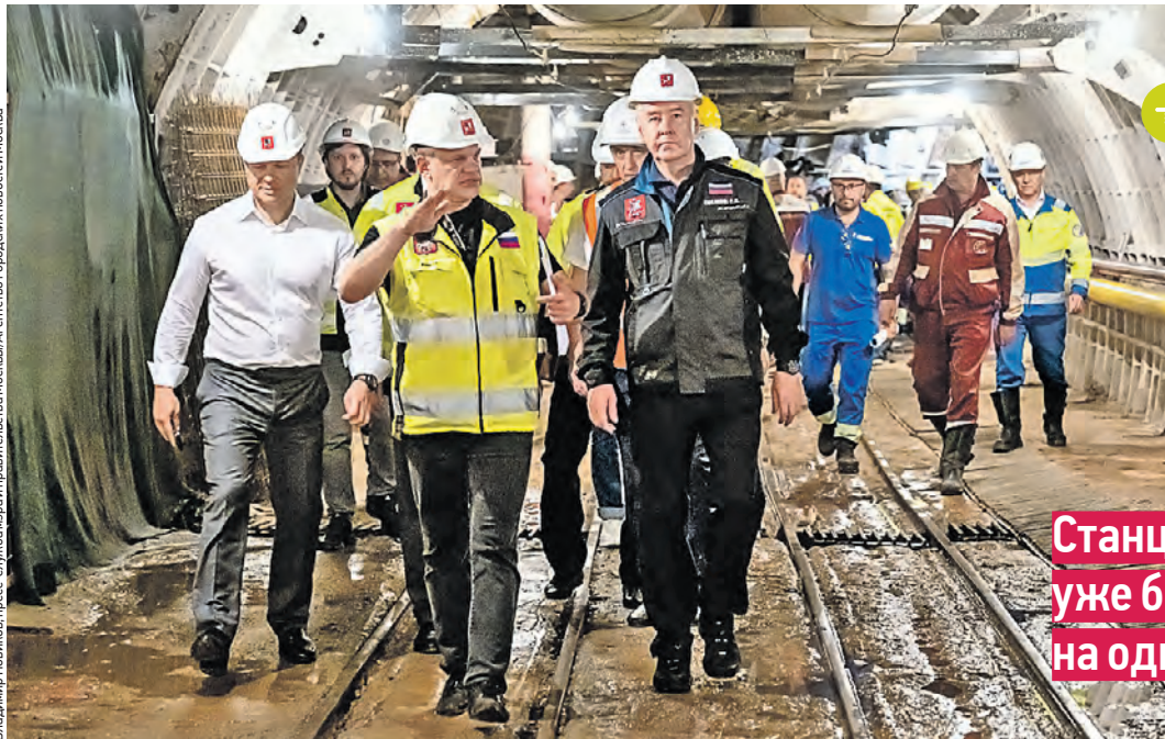
15 июля 2024 года. Мэр Москвы Сергей Собянин (в центре) посетил строительную площадку станции «Достоевская» Кольцевой линии метрополитена
