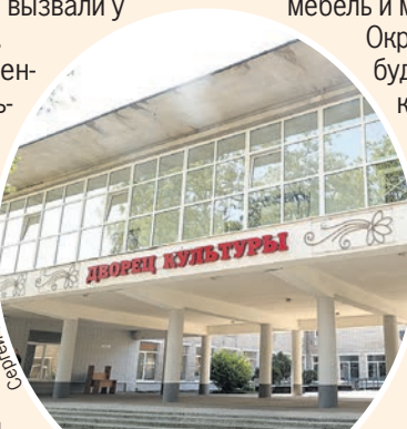
Сейчас работы проходят внутри здания. Фасад приведут в порядок позже.
