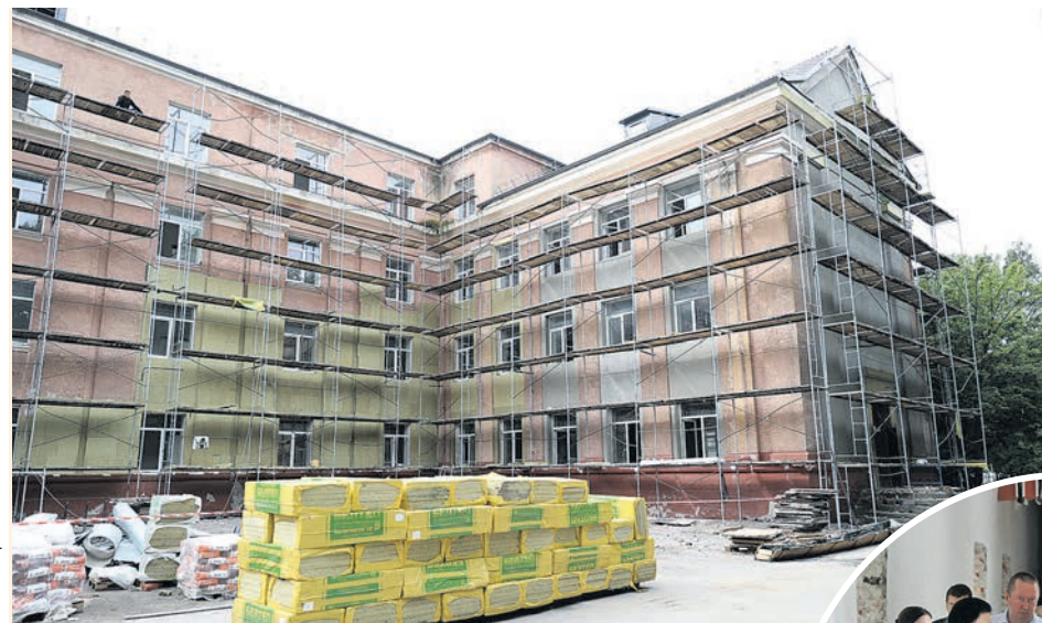
Четырехэтажное здание площадью 5207,9 квадратного метра полностью обновляется.
