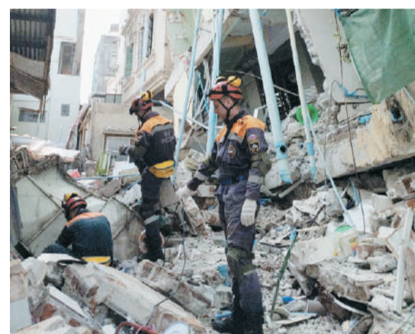
Специалисты МЧС принимают участие в ликвидации последствий жуткого землетрясения.
